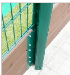
mocowanie płyty do profilu
